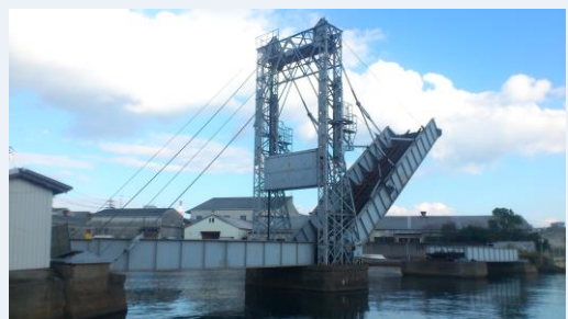
カウンターウエイトが上昇、橋桁が下降
