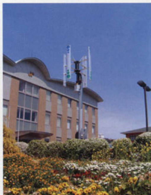
鳥羽市商工会議所に設置の風力発電システム
